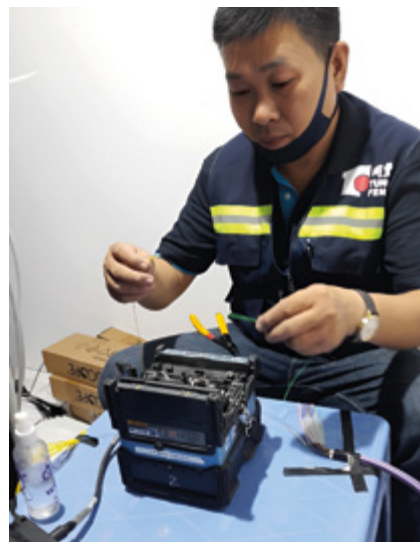
Der VUSS-Projektmanager beim Spleißen der Kabel
