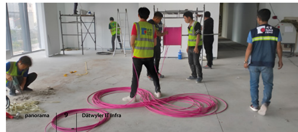
Abrollen der OM4-Kabel vor der Installation
