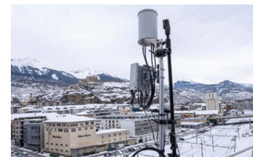
Die mobile Antenne mit 5G-Micro-Remote-Head
