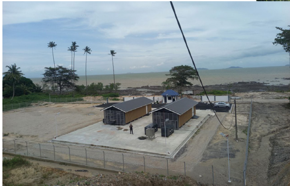
Die Kabellandestation am Standort Mersing
