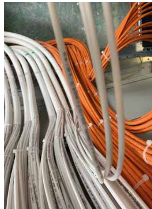
光纤通过气吹技术敷设于柔性管道系统（左）
