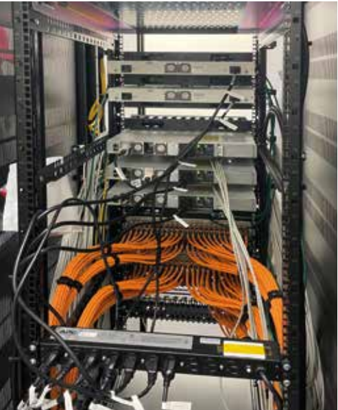
配备铜缆与光纤连接的网络机柜
