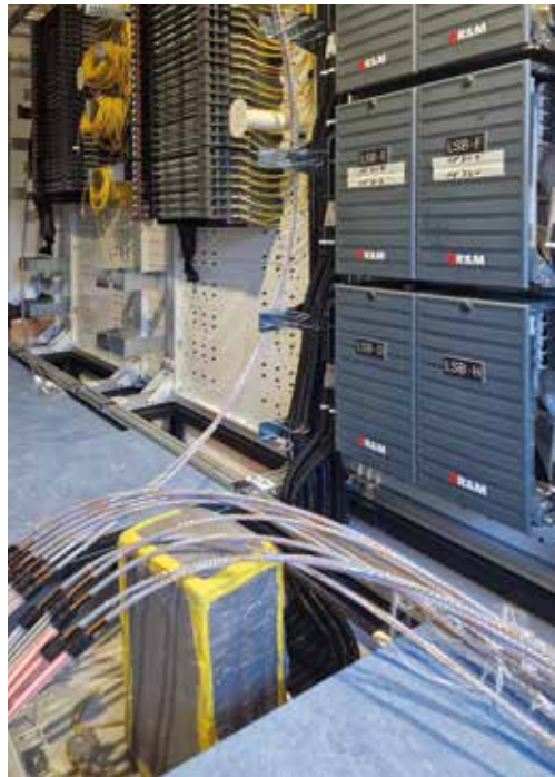
线缆引入接入点 长途网络与服务连接接入网的接口
