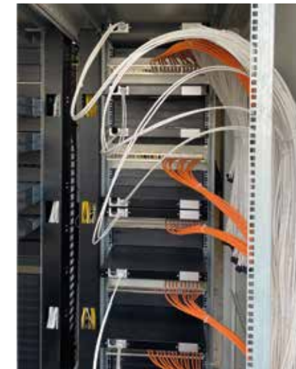
数据配线间内的铜缆与光纤配线架
