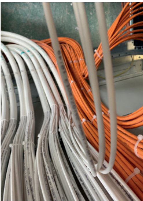
Die Glasfasern sind in ein flexibles Rohrsystem eingeblasen (links).
