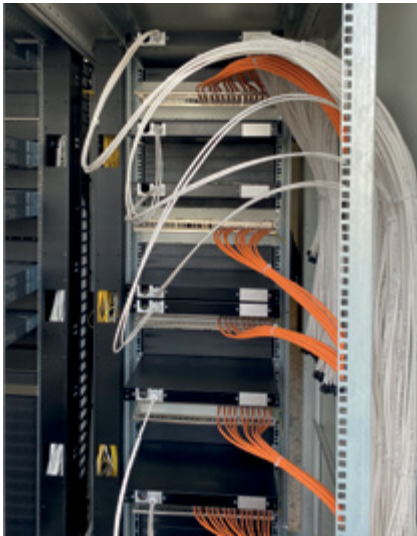
Kupfer- und Glasfaserpanel in einem Datenverteillerraum
