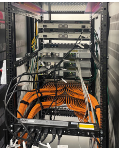
Datenrack mit Kupfer- und Glasfaseranschlüssen
