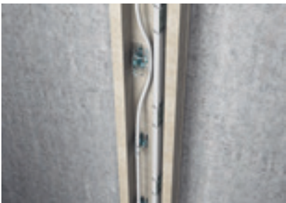
Senkrechte Kabelverlegung mittels Leitungshalter
