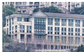
重庆名匠集团区域总部数据中心
