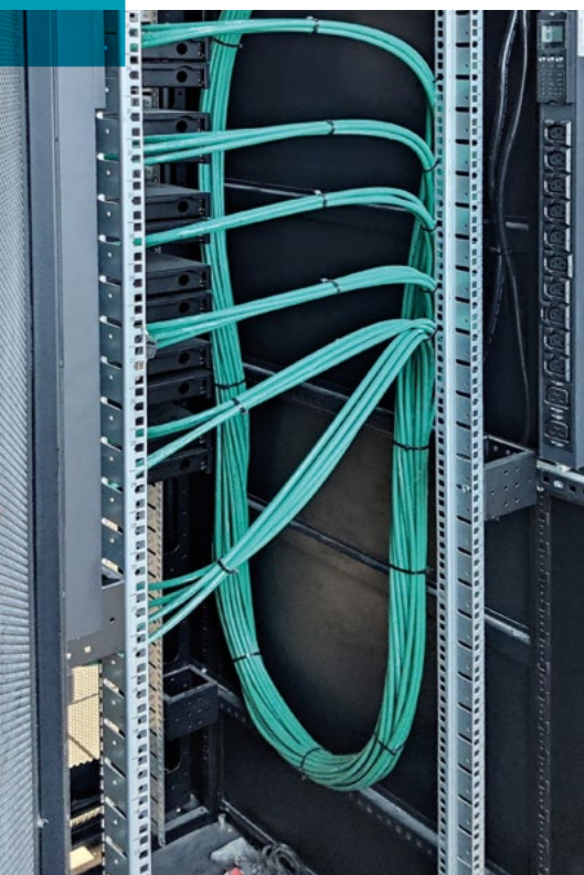
Installation von Glasfaserkabeln im Rack
