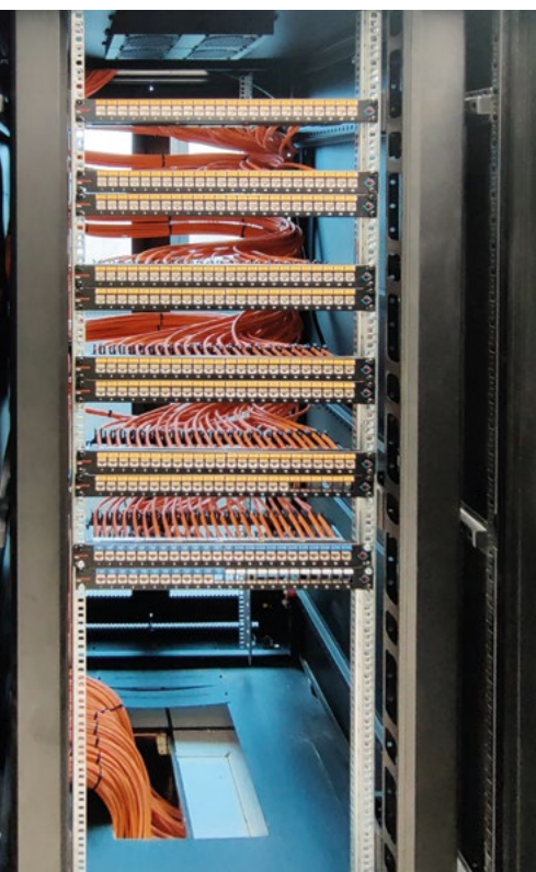
Installation der Kommunikationsverkabelung im zentralen IT-Raum
