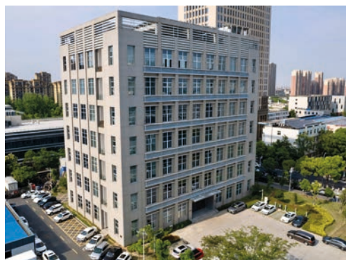
位于合肥包河区的电力调度大楼
