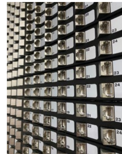
Panel mit gewinkelten RJ45-Modulen
