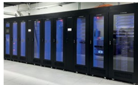
Das von Dätwyler für Obhur City gelieferte »smarte« modulare Mini-Rechenzentrum
