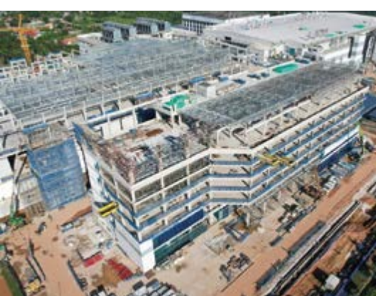
Baustelle des neuen AT&S-Werks in Kulim
