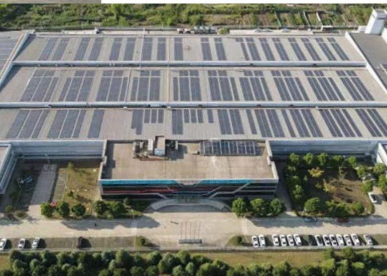
Grüner Strom vom Dach des Werks in China.
