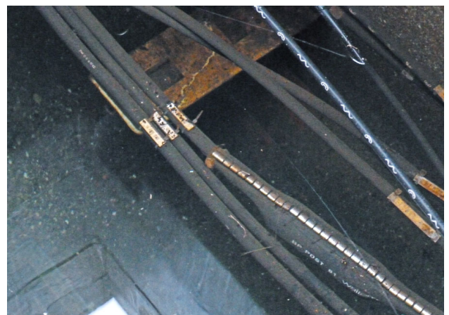
Caso estremo: condotto completamente sott'acqua.
