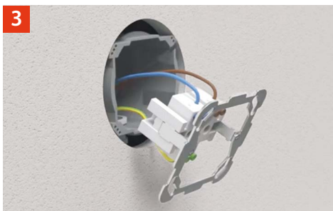
... und die Dose ein wenig nach vorne ziehen. (Die Drähte bleiben angeschlossen)
