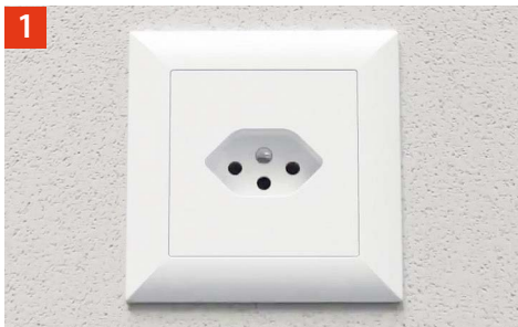
Beispiel: Nachrüsten einer Steckdose.
