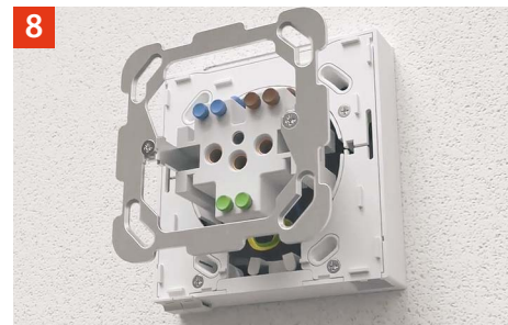
Verschlusssteil einsetzen ...
