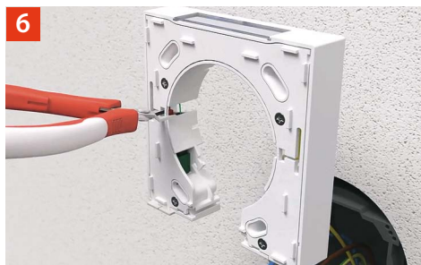
Falls Box gespreizt werden muss: Verschlusssteil entfernen und Steg mit Zange schneiden.
