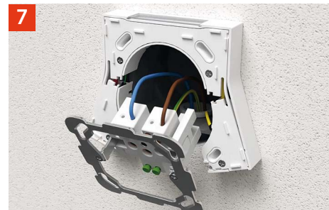
Die Squeeze-Box kann bei Bedarf gespreizt werden.
