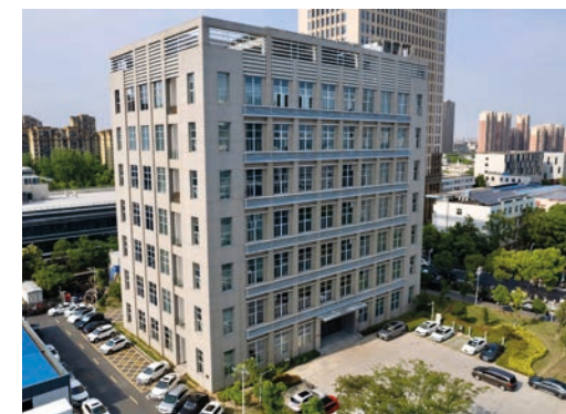
位于合肥包河区的电力调度大楼
