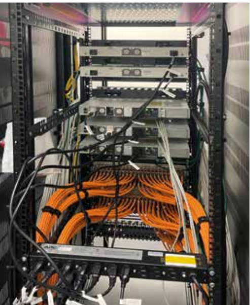
配备铜缆与光纤连接的网络机柜
