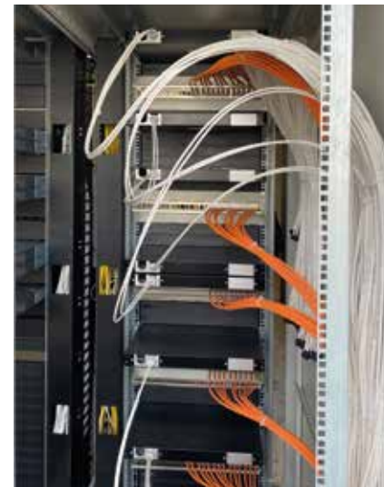
数据配线间内的铜缆与光纤配线架
