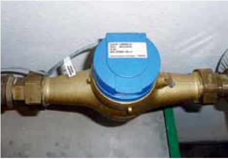
在州档案馆中的可通讯燃气表 Communication-compatible gas meter in the State Archive.
