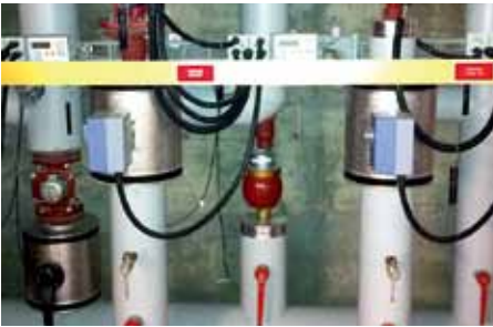
在Promenade管理大厦中的带有通讯界面的热量表 Heat meter with communications interface in the Promenade administration building.
