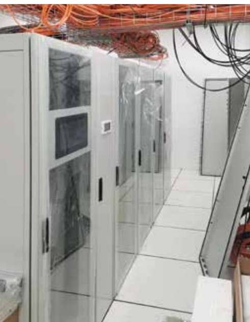
慕贝尔汽车部件公司安装的 迷你微模块数据中心
