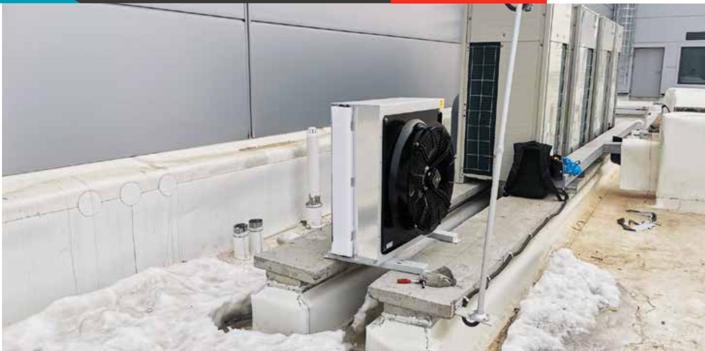
给迷你微模块数据中心安装空调单元
