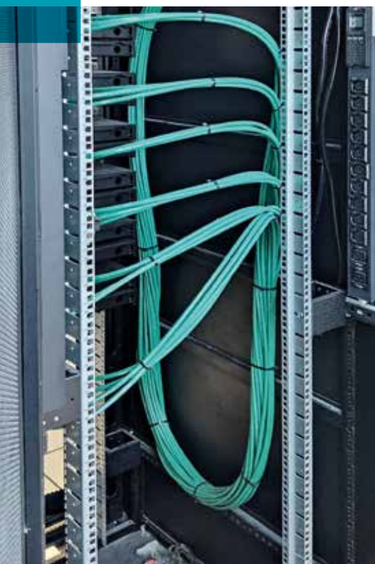
机柜中光缆的安装
