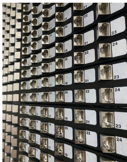
安装角形RJ45模块的配线架
