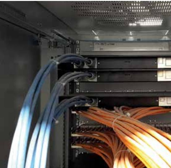
跨越各层的网络包括近 100 公里长的 Cat.7 铜缆, 以及屏蔽的 Cat.6A 连接技术, 包括 6000 个模块和 100 个配线架。在各房间中, 数据线被连接到各种设施上, 包括一个迷你开关, 用来为旅客提供高分辨率电视和高速无线网服务。
