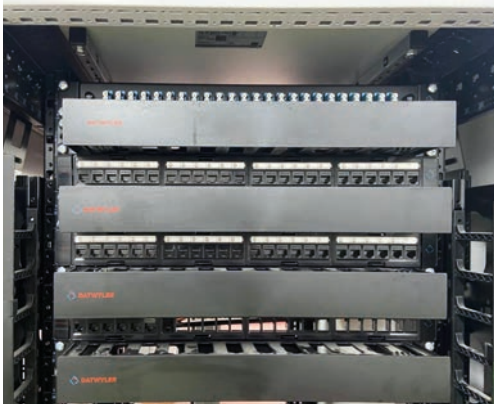
机柜内安装的配线架
