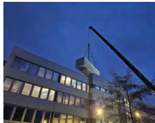
将数据中心集装箱吊至汉堡总部楼顶
