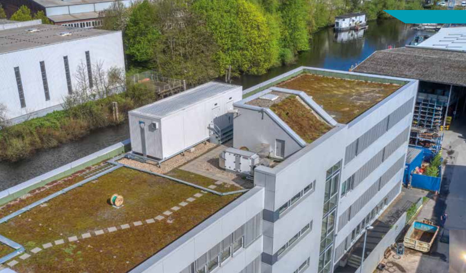
当前的数据中心集装箱如图所示
