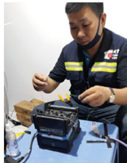
VUSS项目经理正在熔接光缆
