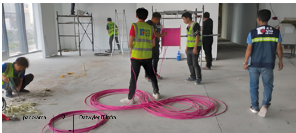
安装前展开OM4电缆
