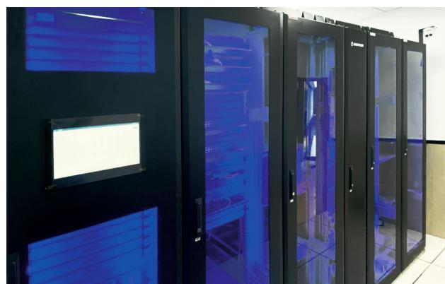
Mini-Datacenter ist ein All-in-One-System mit integrierter Klimatisierung, Energieverteilung, unterbrechungsfreier Stromversorgung (USV) sowie mit intelligenten Umweltüberwachungs- und Management-Systemen. Es besteht aus fünf Racks und einem Präzisions-Reihenkühler und ist ein komplett geschlossenes, insofern sehr energieeffizientes System.
