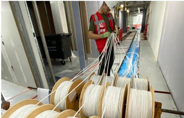
Bündeln aus Kategorie-6<sub>A</sub>-Kabeln. Für die Verbindung der Racks untereinander setzten die Netzwerkinstallateure 24-faserige OM4-Kabel und 74 Kupfertrunks ein, die Dätwyler vorkonfektioniert auf die Baustelle geliefert hat
