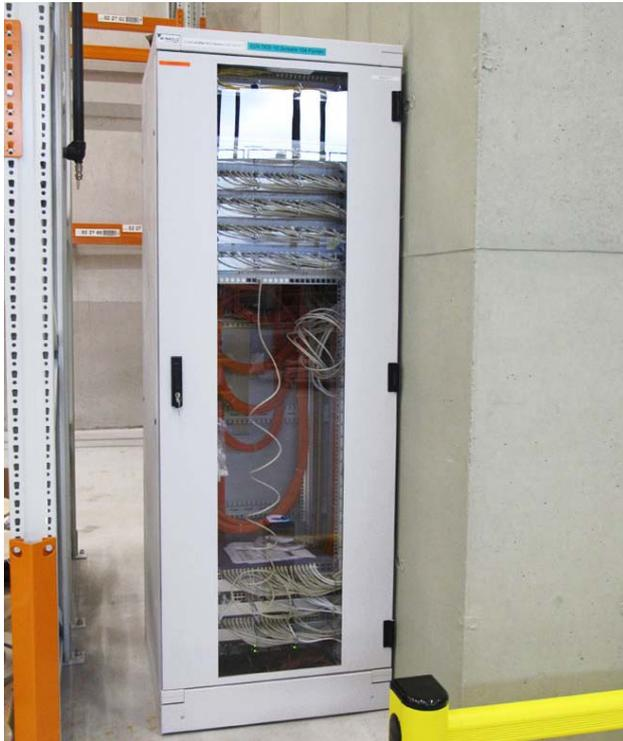
Serverraum ist heute über 24-faserige Singlemode-Glasfaserkabel mit vier Verteilerracks verbunden, die in zwei Technik- und einem Lagerraum im Untergeschoss und in der Verpackung im Erdgeschoss stehen.
