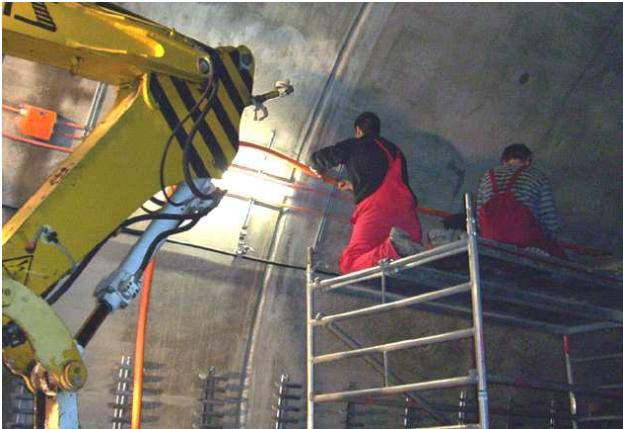
gefordert, die zur Evakuierung benötigt werden. Gerade in U-Bahn-Tunneln können Sicherheitskabel wie diese einen wichtigen Beitrag dazu leisten, die Brandauswirkungen zu minimieren: Zum einen versorgen sie die installierten Sicherheitseinrichtungen über einen ausreichenden Zeitraum weiter mit Strom, zum anderen lassen sich Gesundheits- und Materialschäden vermeiden oder zumindest verringern.
